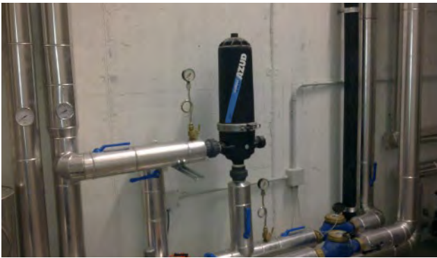
ITALY ITALIA | Cooling tower Refrigeración
